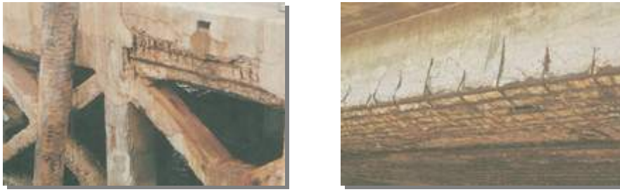
รูปที่ 9. แสดงโครงสร้างถูกทำลายเนื่องจากคลอไรด์ในน้ำทะเล หรือน้ำกร่อย (ที่มา : http://www.learn.in.th , 2539)
